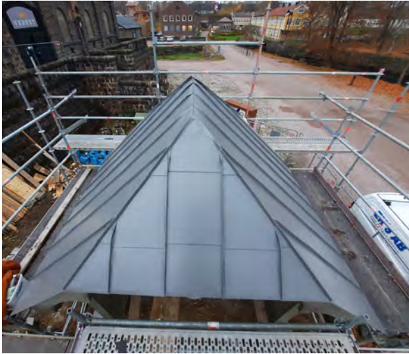
Yttertakens skivtäckning återställd.
