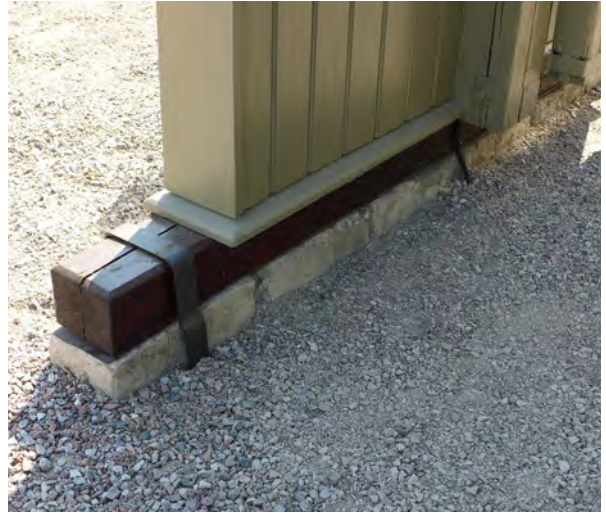
Porten är nu uppställd på grusad betongplatta med trätjärad syll och slaggsten.
